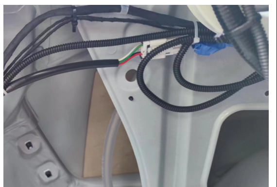
4. 连接后接线器使用电工胶布缠绕包裹裸露的线头，使用扎带在靠近插座端固定线束。
